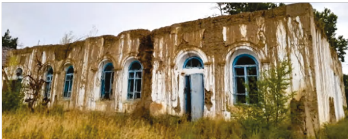
Рис. 8. Современное состояние здания бывшей таможни в Зайсане. Фото С. В. Киселевой, 2024 г.
