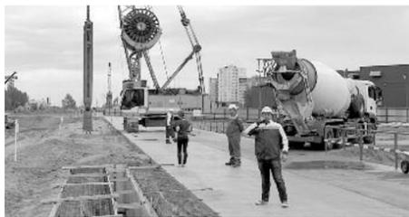
— На сегодняшний день на строительной площадке будущей станции метро «Стрелка» мы закончили ограждение и монтаж камеры для щитов. Сейчас одну машину переводим на улицу Марата, где также необходимо установить монтажную камеру, — рассказал генеральный директор Главного управления по строительству и ремонту метрополитена, мостов и дорожных сетей Юрий Гаранин.
