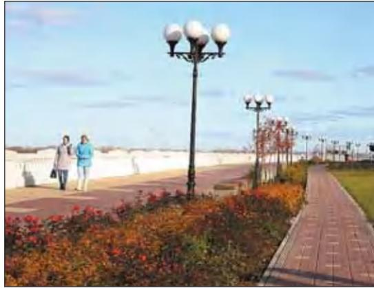
Работы по реконструкции второй очереди Нижневолжской набережной на участке от катера «Герой» в сторону паромной переправы практически завершены. Прогулочная зона сильно изменилась в лучшую сторону. Здесь полностью переложили инженерные коммуникации, вместо старого асфальтового покрытия положили брусчатку и уложили бортовой камень, установили красивую балюстраду и современные светильники. Планируется разместить здесь и малые архитектурные формы.
