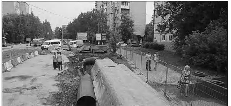
В Московском районе на пересечении улиц Березовской и Буревестника полным ходом идет реконструкция магистральной теплотрассы V очереди от Сормовской ТЭЦ. На объекте производится замена труб диаметром 500 миллиметров. Изношенные трубы требовали срочной замены, ведь за последние два года на этом участке теплотрассы устранили несколько аварий.
