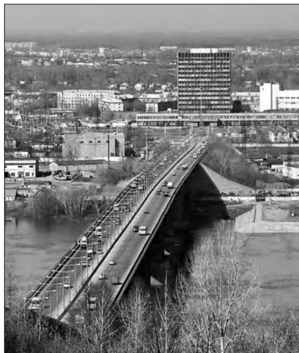
В том, что Молитовскому мосту необходим срочный ремонт, ежедневно убеждают все нижегородцы, которые через этот мост едут. Поддерживающий ямочный ремонт переправы был завершен в апреле, в его рамках было отремонтировано 1987 кв. м полотна, но дорожное покрытие требует более серьезного ремонта. На прошлой неделе первый заместитель главы городской администрации Сергей Миронов сообщил о том, что муниципалитет планирует провести его уже в этом году.
