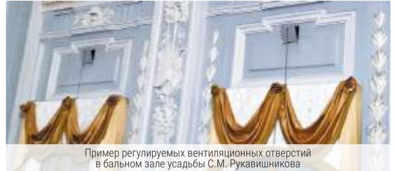
Пример регулируемых вентиляционных отверстий в балльном зале усадьбы С.М. Рукавишниковых
