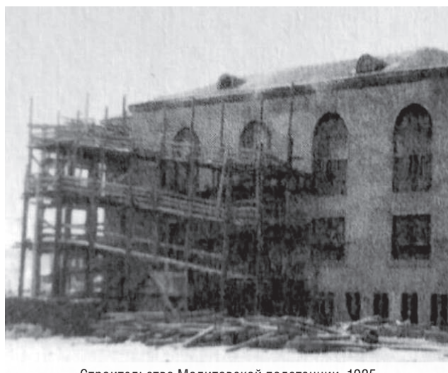
Строительство Молитовской подстанции, 1925
